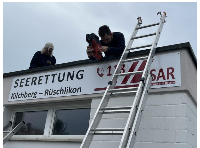
Beschriftung des Gebäudes auf der Süd- und Ostseite.
